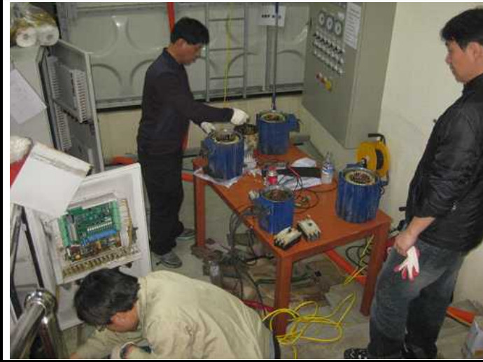
배수 후 복구작업(모터류 절연측정 및 보강)
