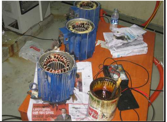
배수 후 복구작업(모터류 절연측정 및 보강)
